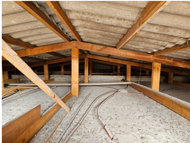
TELHAS DE FIBROCIMENTO E ESTRUTURA DE MADEIRA NA VT DE IRATI
