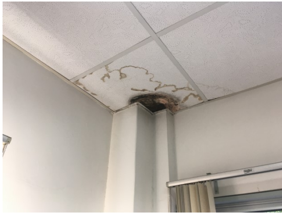
MANCHAS DE UMIDADE NO FORRO DO FT DE ARAUCÁRIA, DECORRENTES DE VAZAMENTO DA COBERTURA
